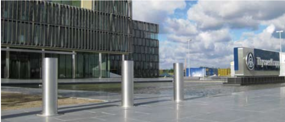
TKQ 1: Die neue Konzernzentrale ThyssenKrupp in Essen
